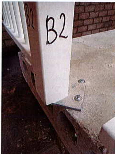
Foto 4: bevestiging VRIHÉSPIL aan kanaalplaatvloer
