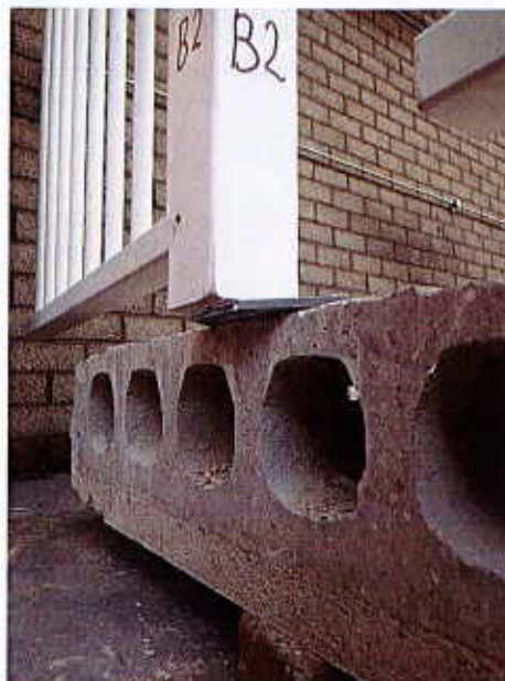
Foto 5: bevestiging VRIHÉSPIL aan kanaalplaatvloer
