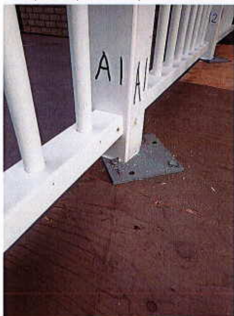
Foto 2: bevestiging VRIHÉSPIL aan houten vloer
