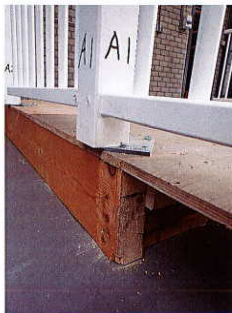
Foto 3: bevestiging VRIHÉSPIL aan houten vloer
